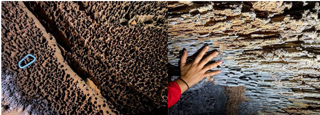
Photo 3 : Corrosion dans Tham Houay Say
